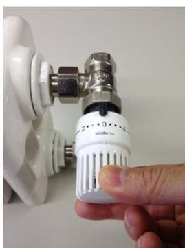
10. In estate posiziona la manopola sul 5 per non forzare l'otturatore sulla sede e quindi ripristina in inverno la consueta configurazione stabilita per ogni testina.
